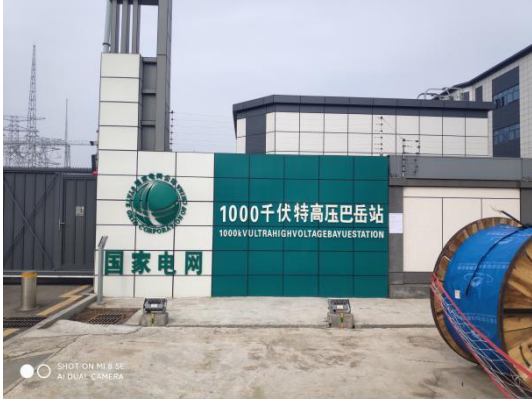
1000 千伏特高压巴岳站门口
